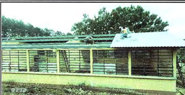
Foto1: Lijada y pintada de costaneras, luego colocación de láminas nuevas.
