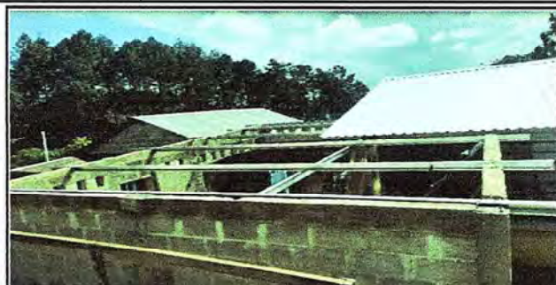
Foto 2: Colocación de costaneras de metal de cocina y un aula.
