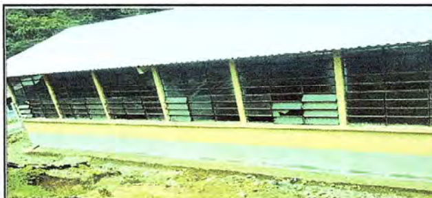
Foto 5: Repello atrás de dos aulas y Dirección.
