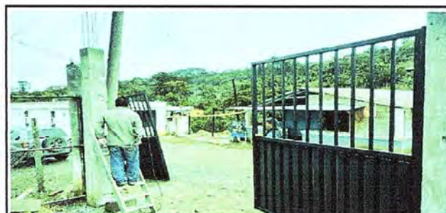
Foto 4: Sustitución y Ampliación de Portones de malla por Portones de Metal.
