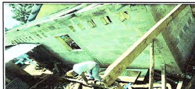
Foto 6: Ampliación de cocina de block y entechado nuevo.
