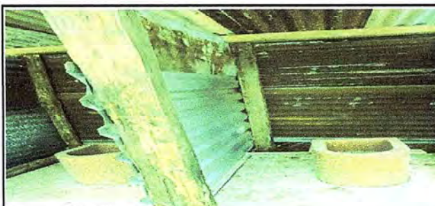
Foto 9: Sustrucción de Dos Letrinas de madera por Dos Letrinas de Concreto.
