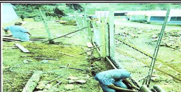
Foto 7: Sustrucción de un lado alto de muro dañado por muro nuevo con malla nueva y postes de concreto.
