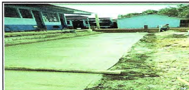
Foto 10: Ampliación de piso rústico en corredor de dos aulas y dirección.
